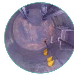
pozos de bombeo
