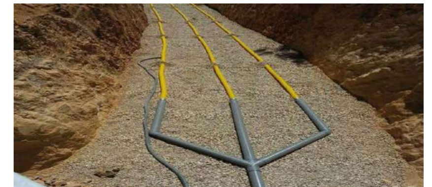
Tubos de drenaje sobre grava en zanjas
