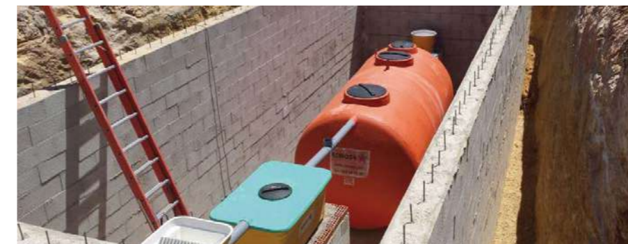
Instalación depuradora perfil hidráulico
