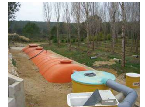
Instalación depuradora perfil hidráulico
