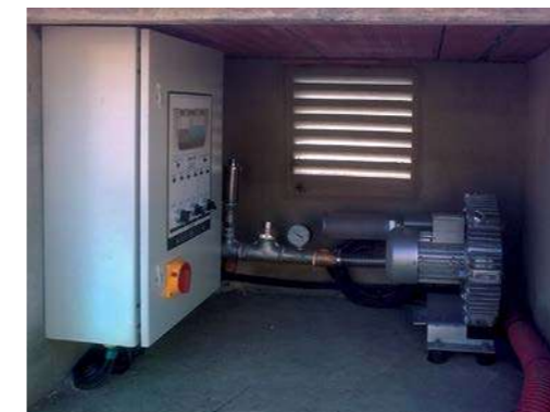
Cuadro eléctrico y compresor
